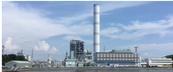
大崎上島 大崎クールジェン構内 カーボンリサイクル 実証研究拠点
