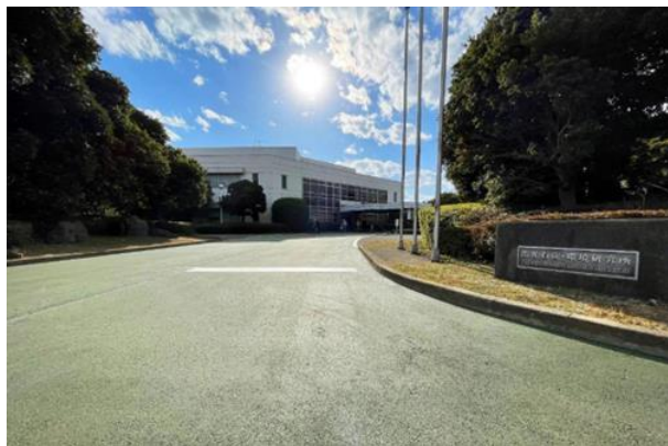
写真2. アスファルト試験舗装
